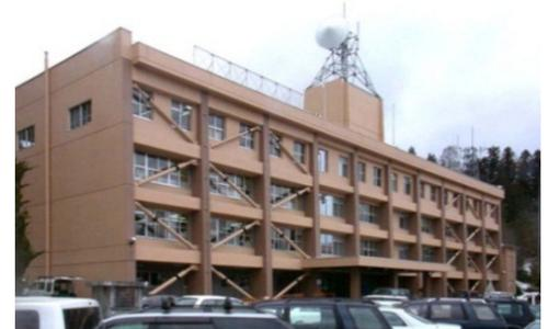
制振装置（オイルダンパー）による補強例
