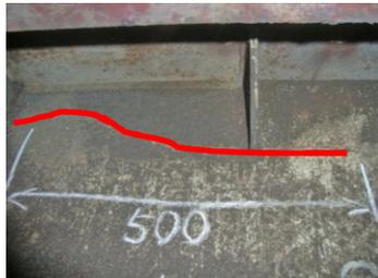
鋼製梁の亀裂箇所検出
