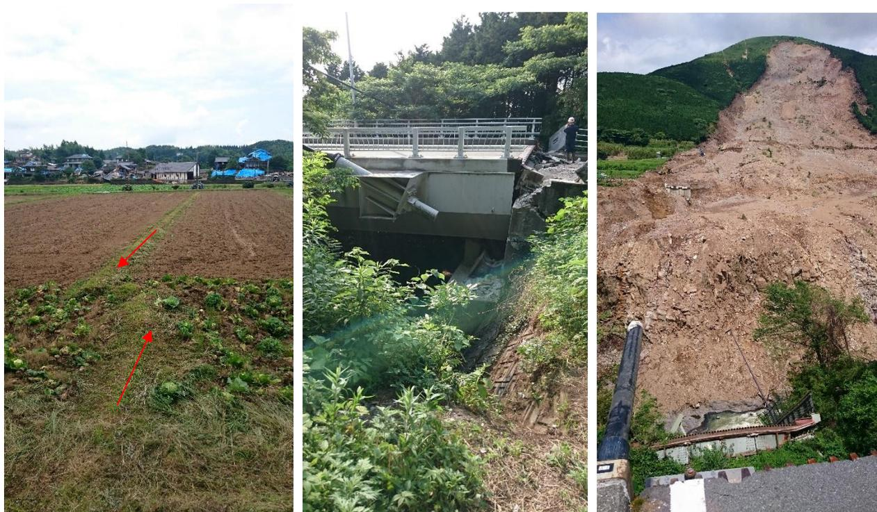
図1 熊本地震における地表地震断層と被害の例
